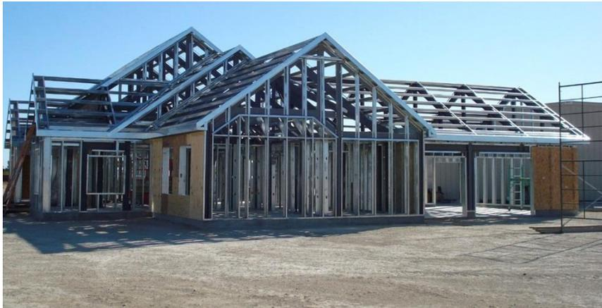
El steel framing es un sistema de construcción que se basa en estructuras metálicas, de acero galvanizado, donde las paredes se conforman con diversas capas de materiales, como lana de vidrio, poliestireno expandido (telgopor), yeso, entre otros. No usa ladrillos y su condición en seco lo independiza de los tiempos de secado de las obras tradicionales y de los vaivenes del clima para avanzar en la construcción.
