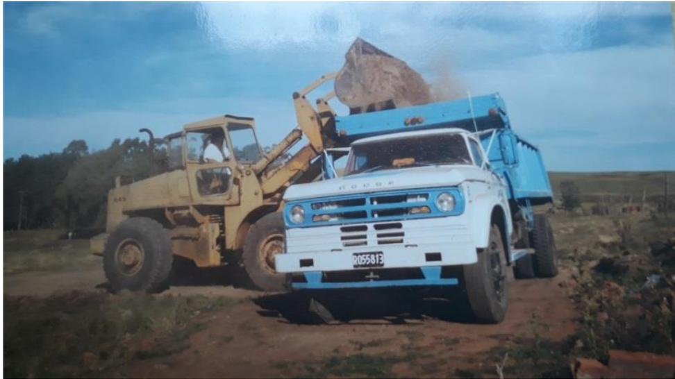
La excavación de la tierra en hornos de pequeña y mediana escala generalmente se realiza a una profundidad menor de dos metros.
